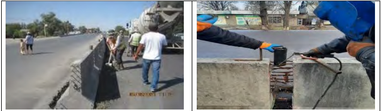
Рисунок 39 Работы по бетонированию канав на проездах между парапетами
