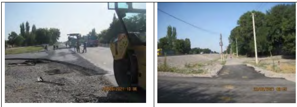
Рисунок 36 Укладка асфальта на съездах на примыкающие к трассе улицы в с. Петровка
