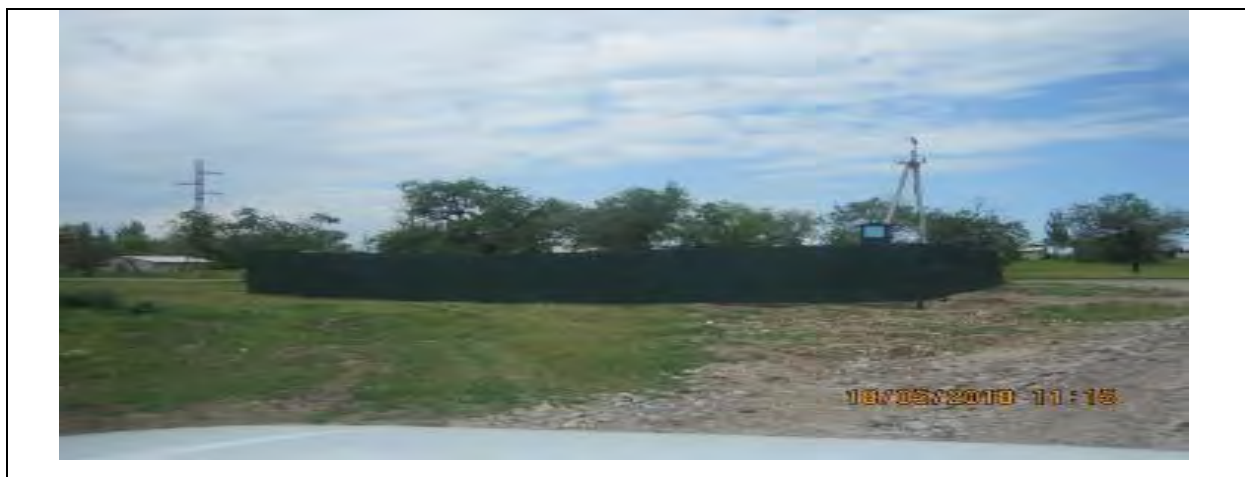
Рисунок 74 Восстановленная скважина для снабжения завода водой
