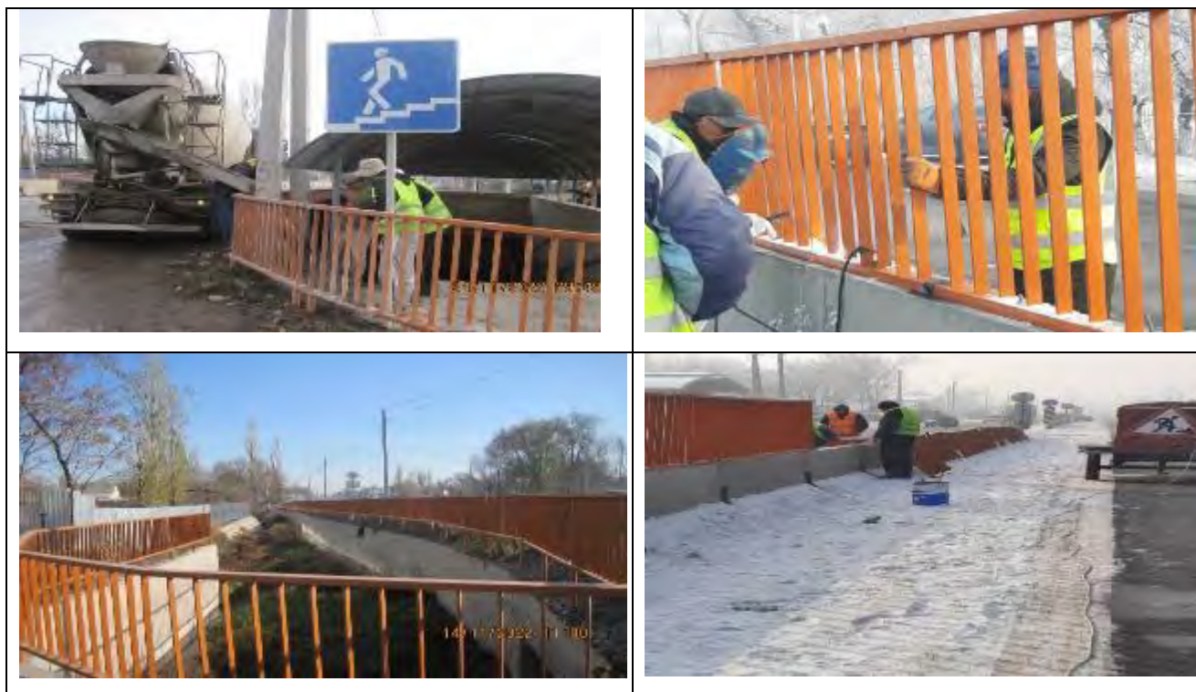
Рисунок 59 Установка металлической решетки в местах строительства дороги
