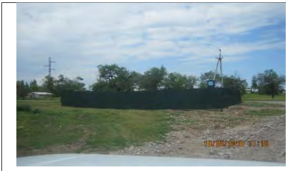
Рисунок 28 Восстановленная скважина для снабжения завода водой
