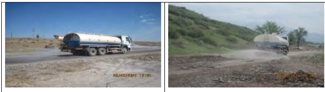
Рисунок 20 Гидроорошение на подъездной дороге к карьеру Ак-Суу2
