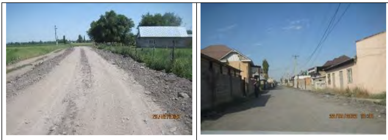
Рисунок 29 Улицы, отсыпанные старым асфальтом
