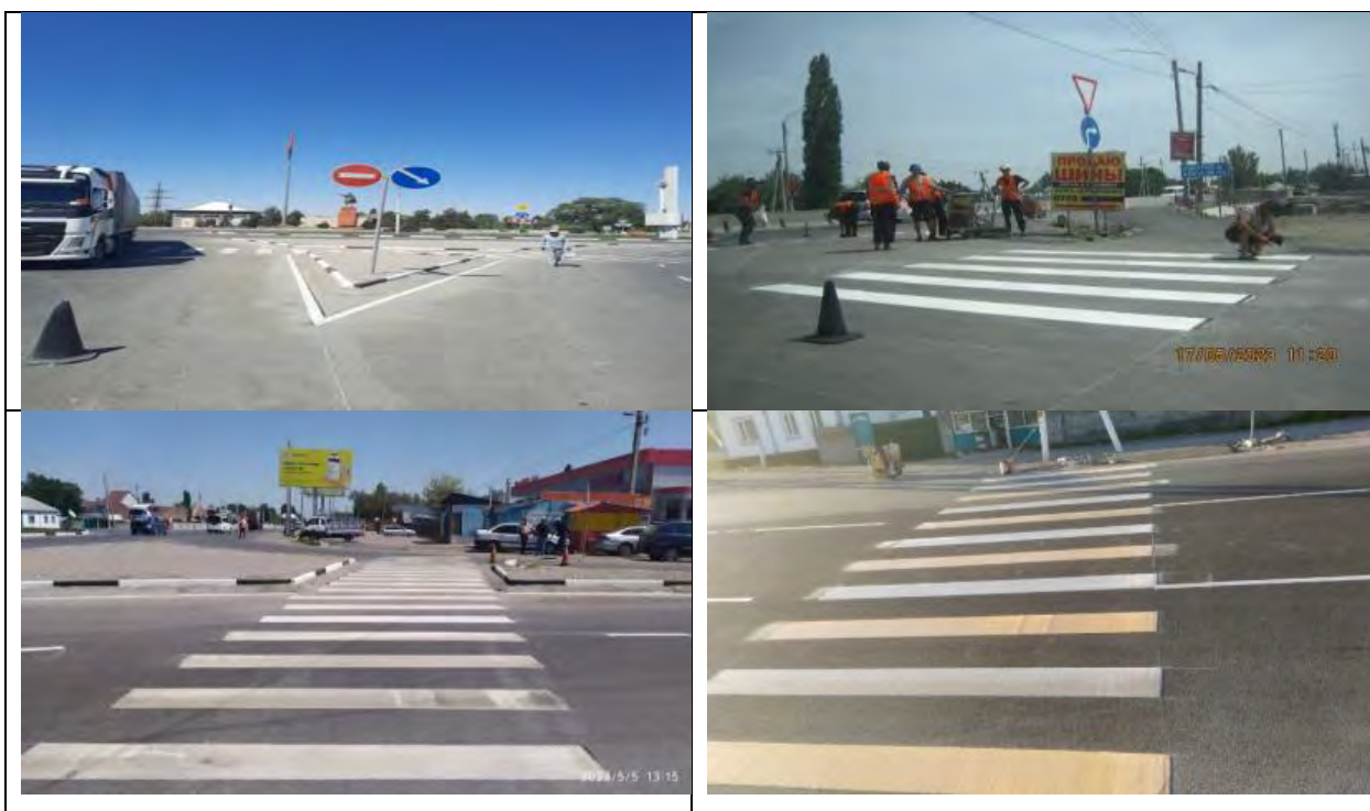
Рисунок 9 Нанесение разметки на дороге
