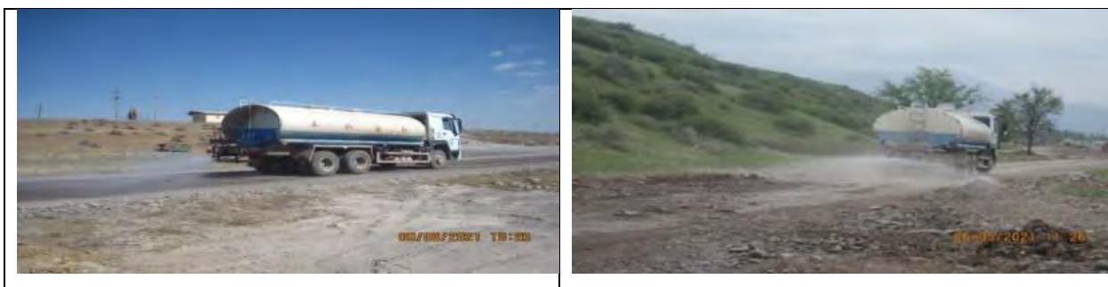
Рисунок 21 Гидроорошение на подъездной дороге к карьеру Ак-Суу2.
