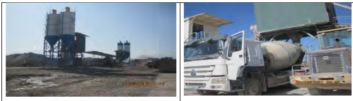
Рисунок 32 Заправка бетоном бетоносмесительной машины
