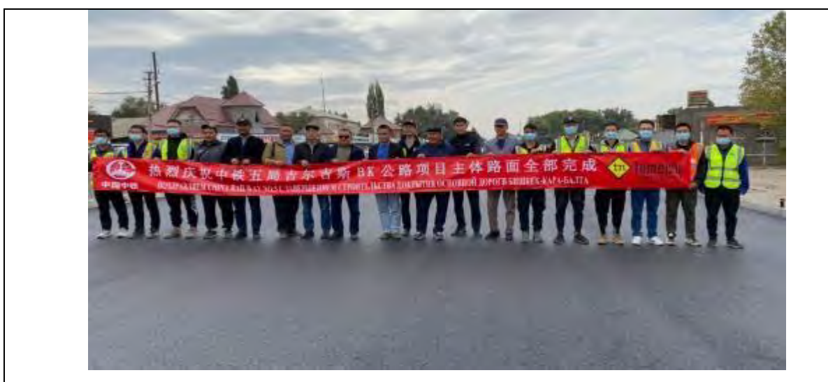
Рисунок 34. Завершение укладки асфальтового покрытия на основной дороге с км 15,9 по км 61
