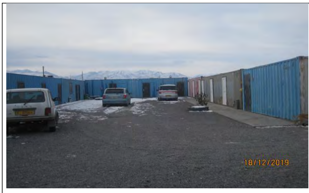
Рисунок 34 Лагерь проживания рабочих на территории промплощадки
