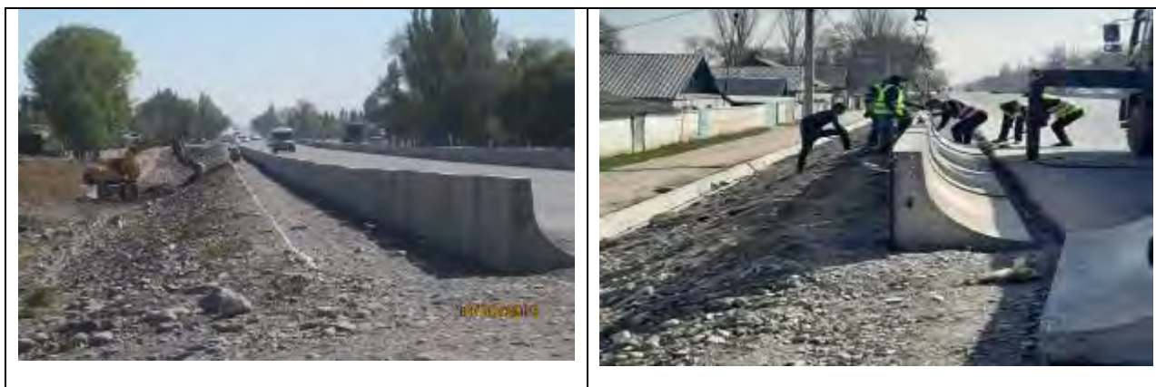
Рисунок 56 Установка дорожных бордюров типа «сапожок».
