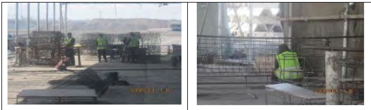
Рисунок 47 Изготовление арматурных сварных сеток, каркасов для изготовления железобетонных конструкций
