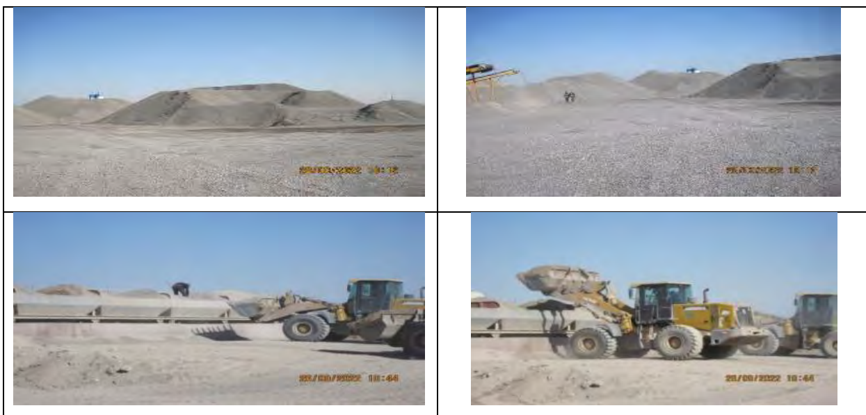
Рисунок 31 Заготовка гравийного материала для производства бетона и асфальта
