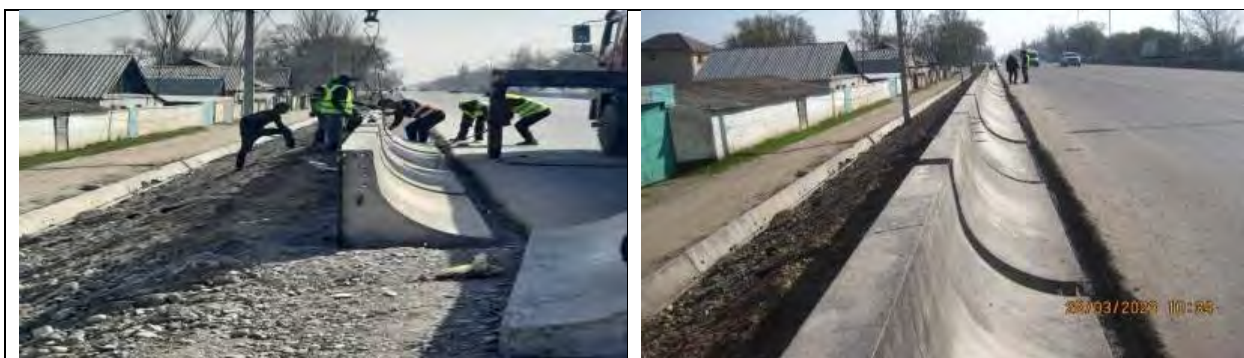
Рисунок 13 Установка дорожных бордюров типа «сапожок»
