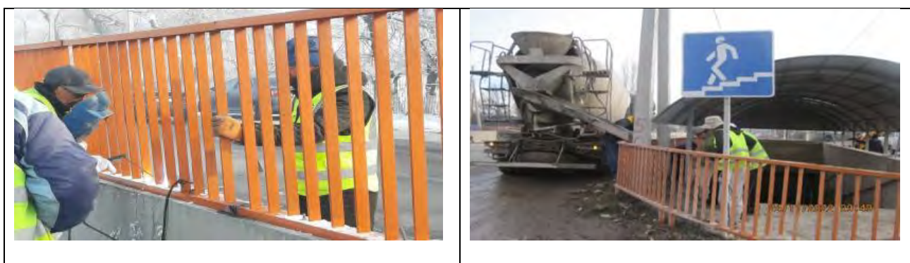
Рисунок 42 Установка металлической решетки возле подземных переходов
