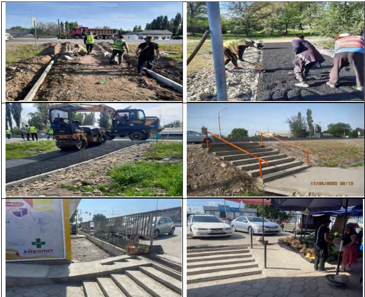
Рисунок 7 Строительство соединительных тротуаров
