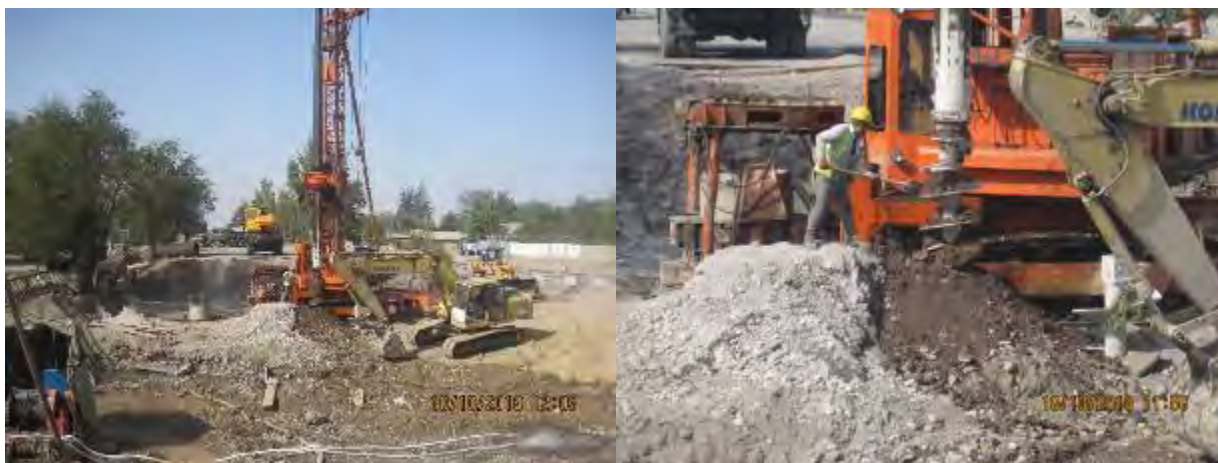
Рисунок 41 Строительство моста через реку Ак-Суу методом бурения на левом берегу
