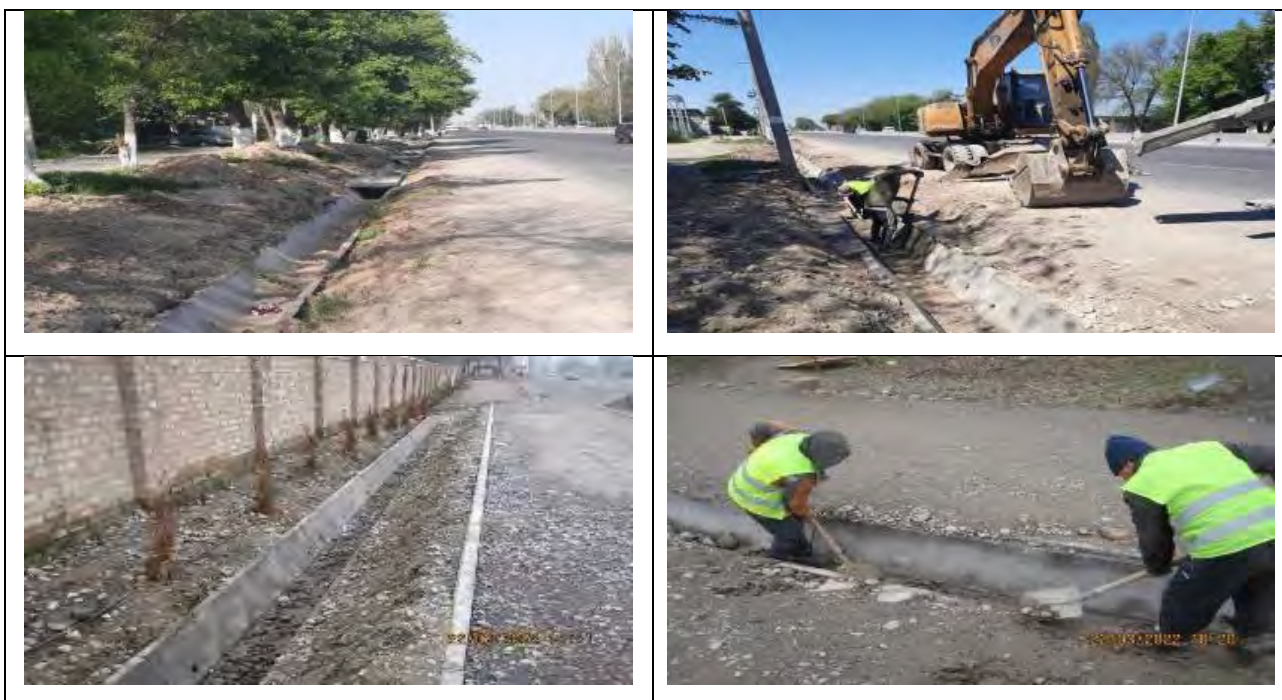
Рисунок 38 Очистка водопропускных лотков
