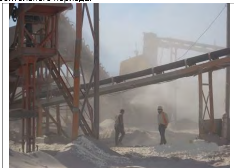
Рисунок 45 Работа камнедробильной установки без гидроорошения
