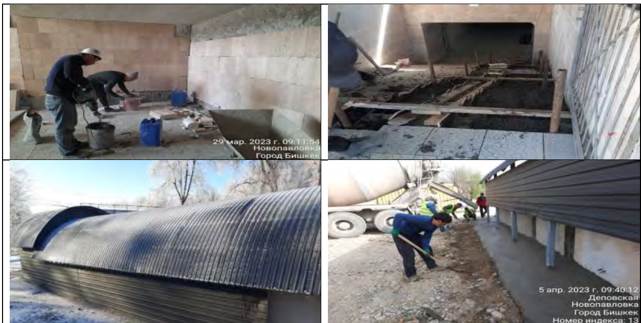
Рисунок 16 Работа в подземных переходах
