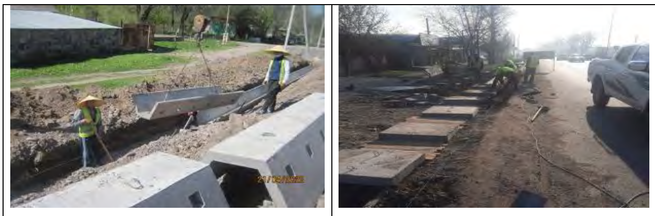
Рисунок 53 Строительство водопропускных лотков
