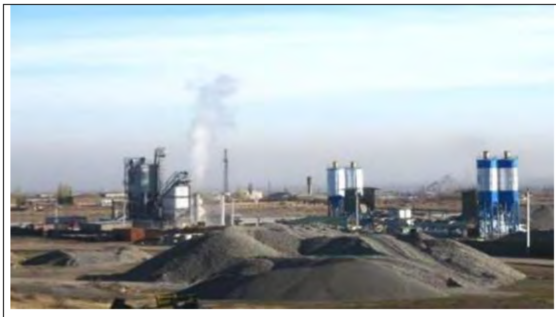
Рисунок 62 Производственная площадка. Бетонно-смесительный завод. Асфальто-битумный завод
