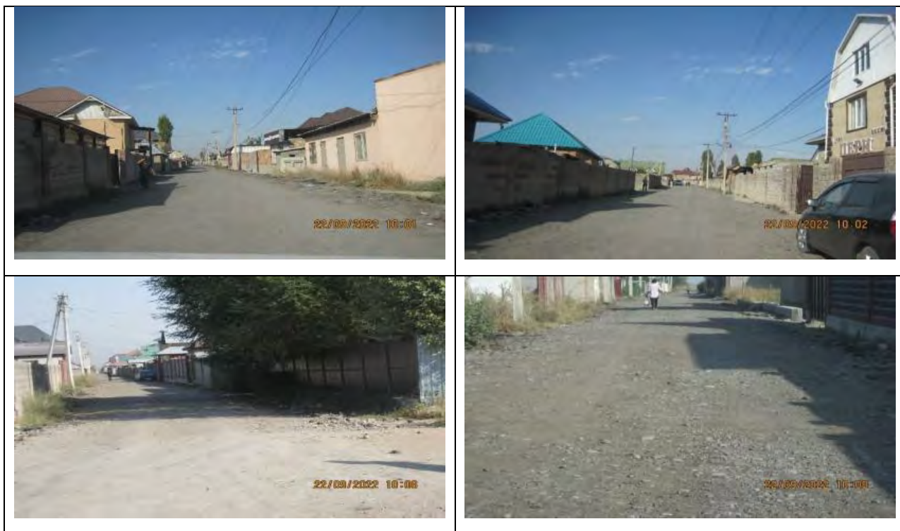
Рисунок 63 Улицы, отсыпанные старым асфальтом на участке км 7.4
