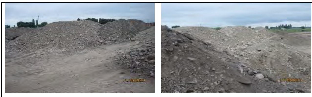
Рисунок 30 Складирование непригодного грунта для дальнейшего использования
