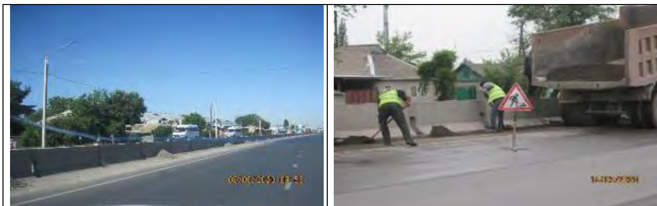
Рисунок 57. Очистка парапетов от земляных отходов и вывоз отходов с дороги
