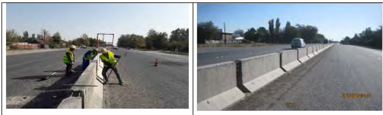
Рисунок 55 Установка разделительных ограждений типа «Нью Джерси».
