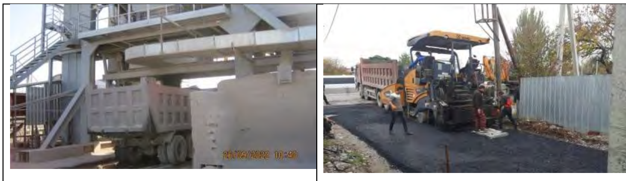
Рисунок 33 Загрузка асфальтовой смеси в самосвалы и выгрузка ее в асфальтоукладчики
