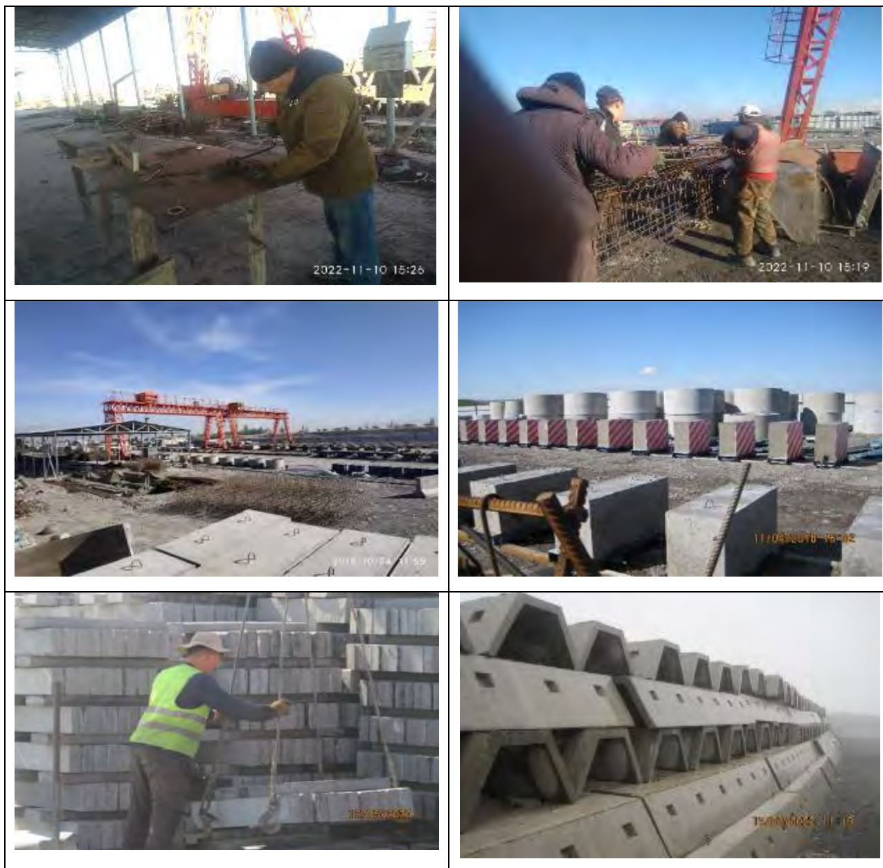
Рисунок 63 Изготовление и заготовка железобетонных конструкций
