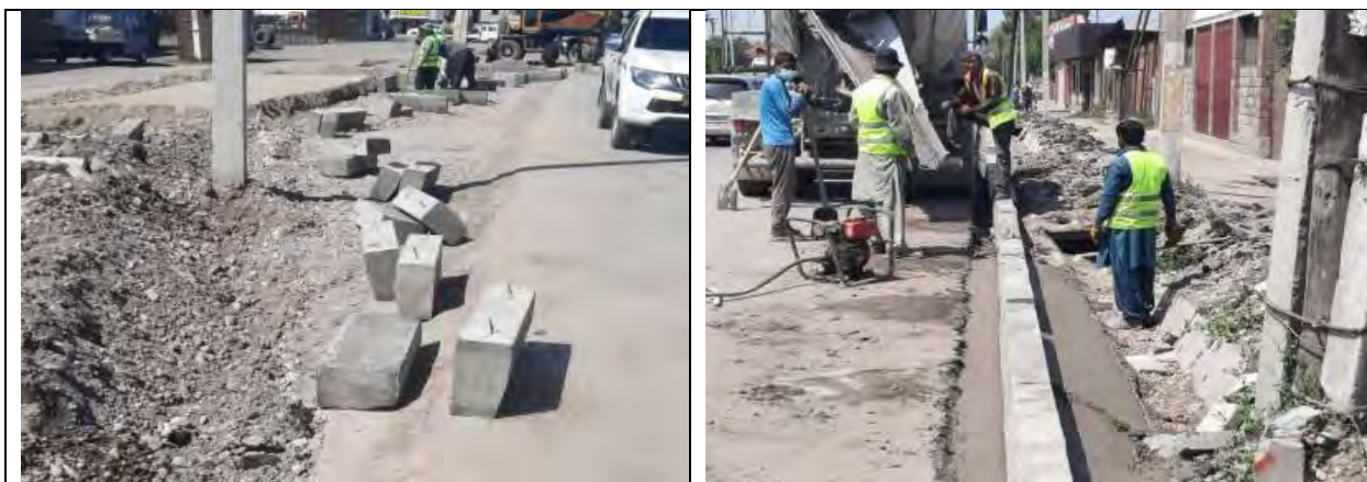
Рисунок 12 Установка дорожных бордюров
