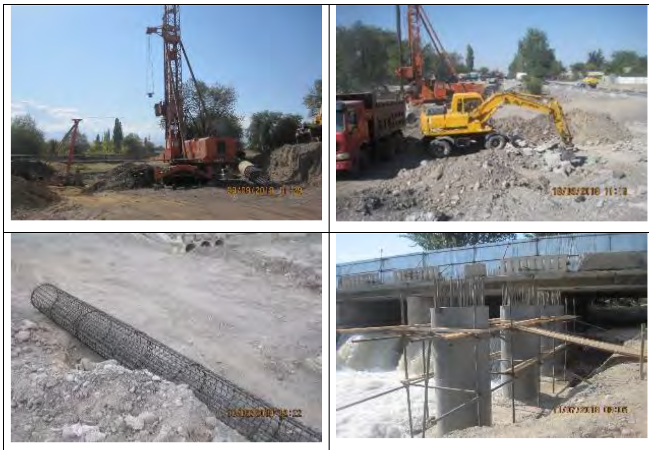
Рисунок 42 Строительство моста через р. Аксуу
