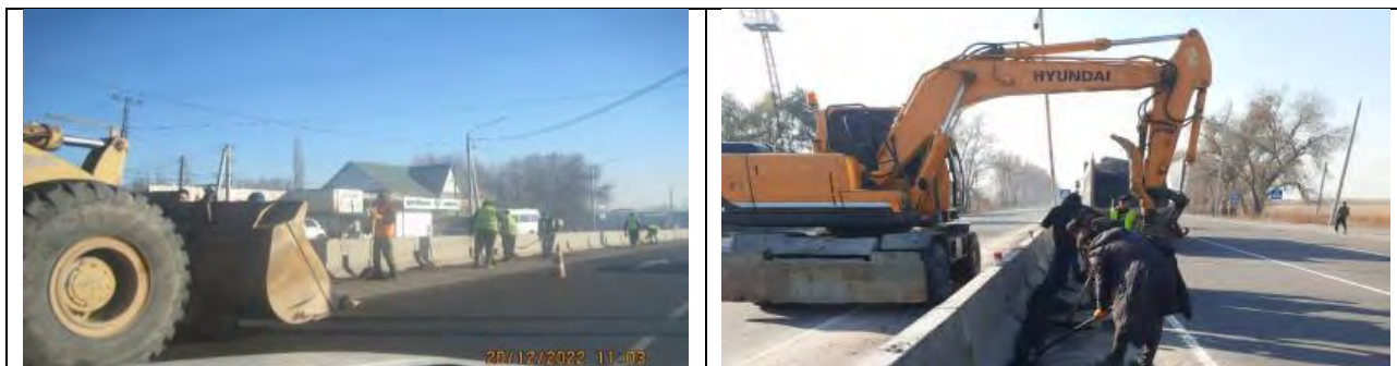
Рисунок 37 Очистка парапетов от земляных отходов и вывоз отходов с дороги
