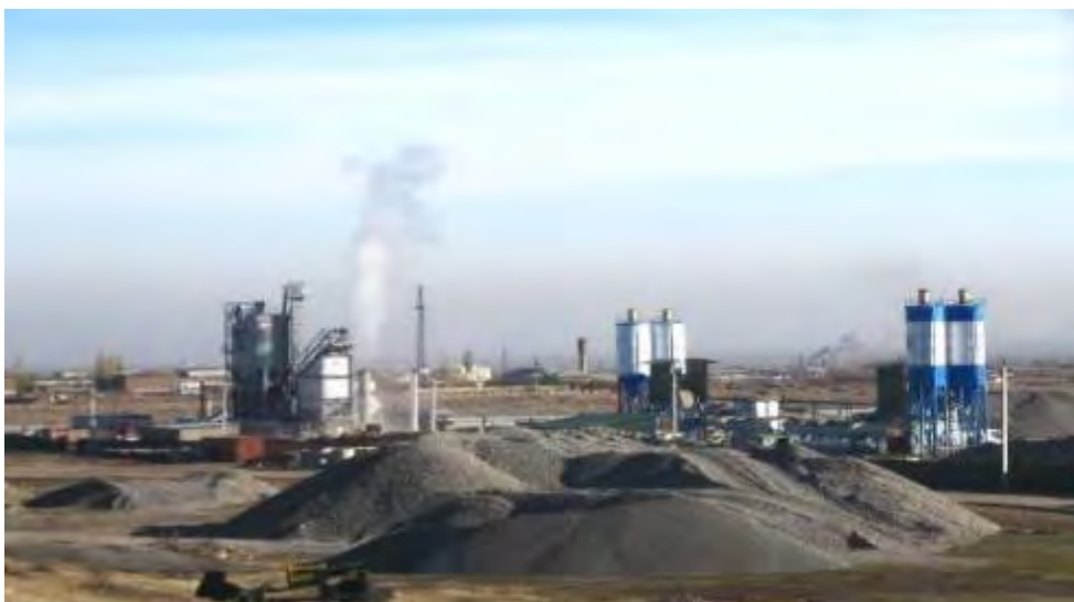
Рисунок 27 Производственная площадка. Бетонно-смесительный завод. Асфальто-битумный завод
