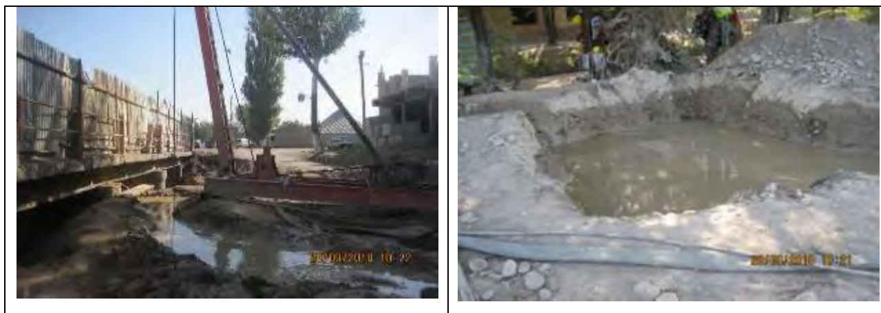
Рисунок 39 Строительство моста через р. Сокулук. Бентонитовая яма
