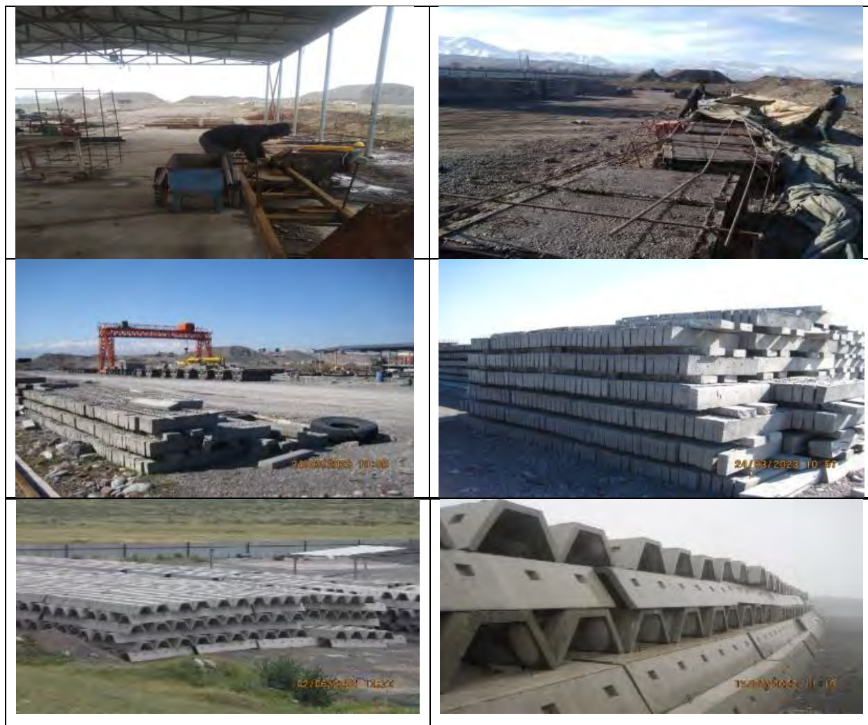
Рисунок 29 Изготовление и заготовка железобетонных конструкций
