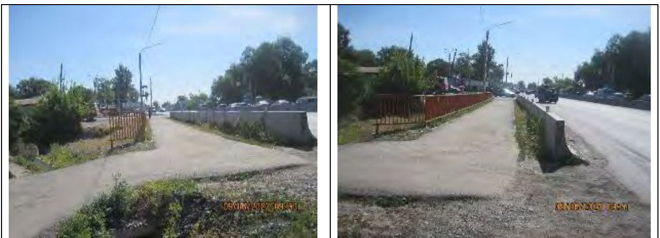
Рисунок 49 Пешеходный тротуар на канале Крепостной на новом мосту
