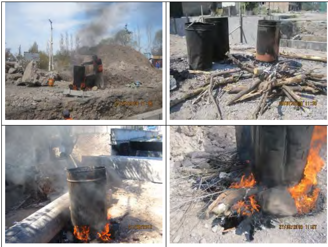
Рисунок 51 Плавка битума для гидроизоляции труб
