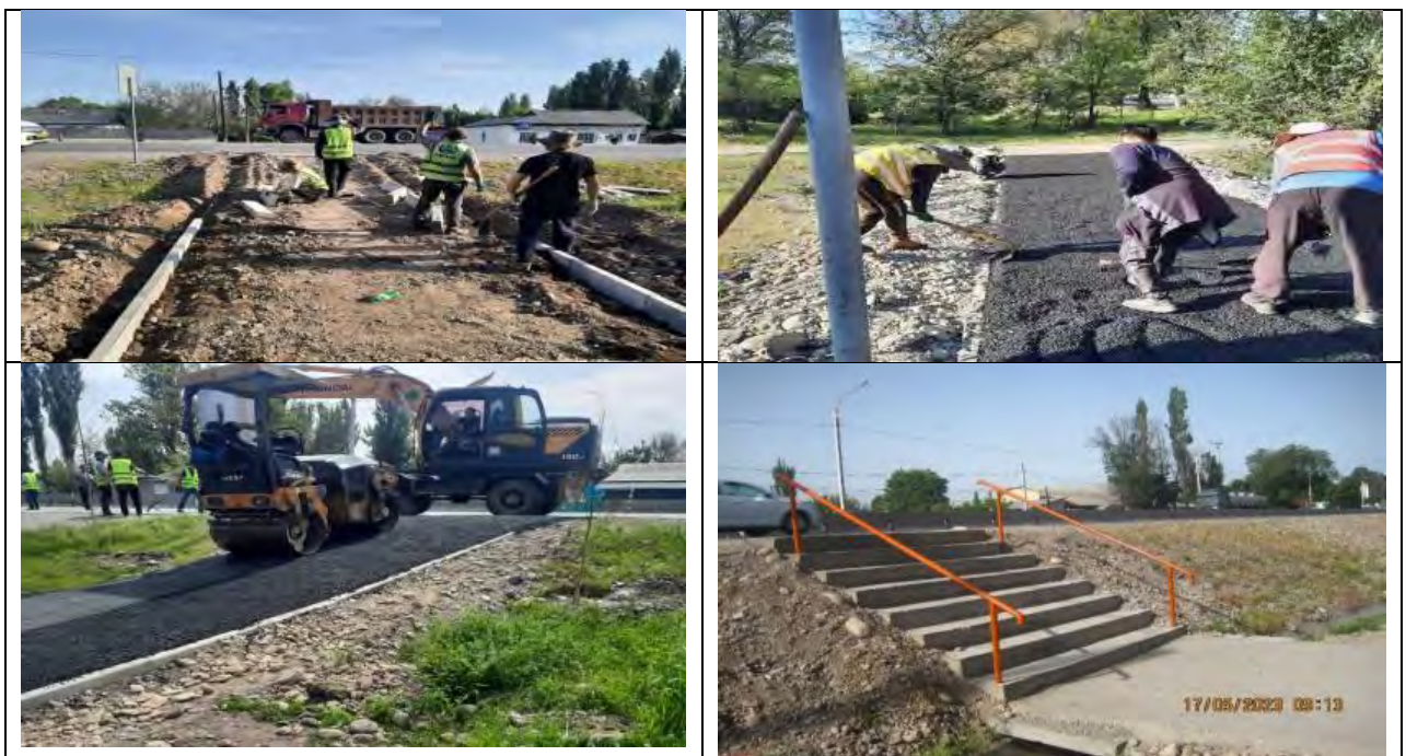
Рисунок 40 Строительство соединительных тротуаров
