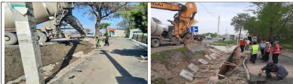
Рисунок 8 Работы по укреплению обочин
