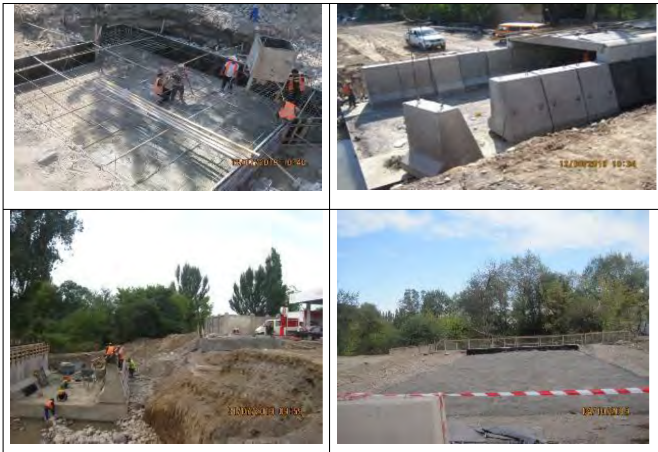
Рисунок 46 Строительство моста на канале Крепостной
