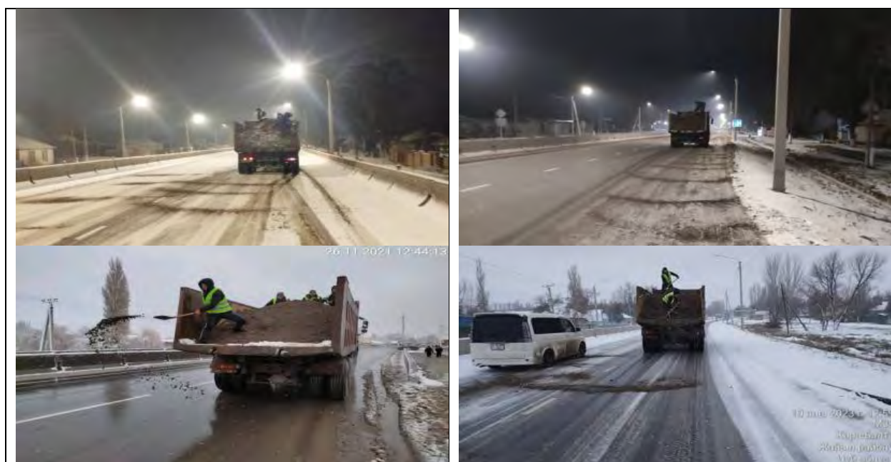
Рисунок 36 Подсыпка песка на дорогу. Борьба с гололедом
