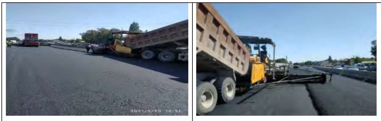
Рисунок 33 Укладка асфальта км 15,9 по км 61
