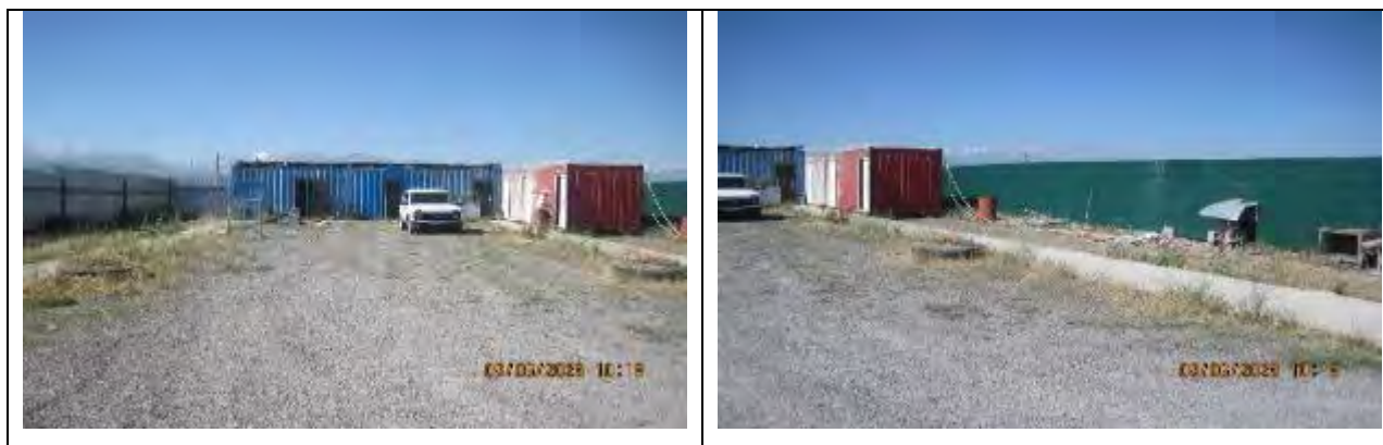
Рисунок 75 Демонтированный лагерь проживания рабочих на территории промплощадки
