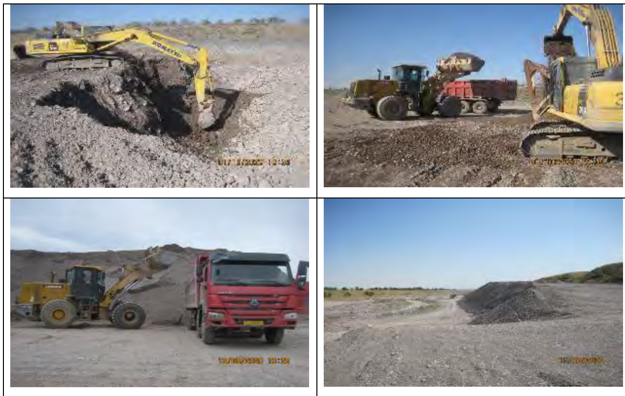
Рисунок 18 Разработка карьера Ак-Суу 2 на увлажненном материале
