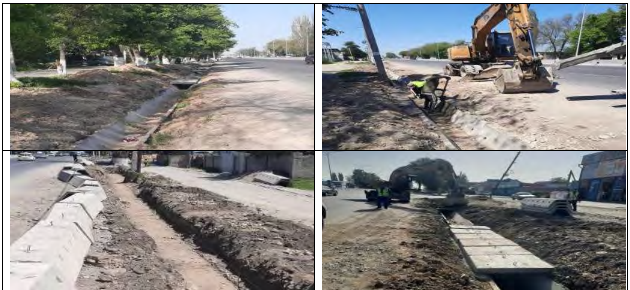
Рисунок 11 Установка водопропускных лотков и плит перекрытия оп 1 на лоток
