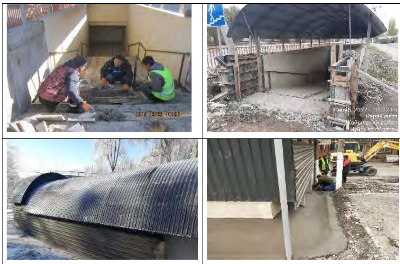
Рисунок 58. Строительные работы на подземных переходах
