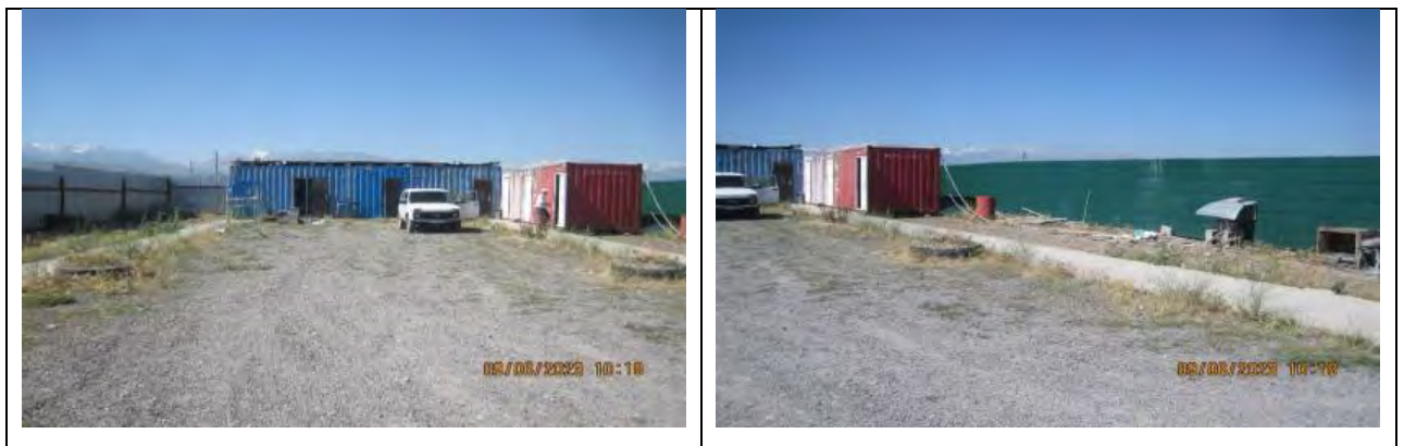
Рисунок 56 Демонтированный лагерь проживания рабочих на территории промплощадки
