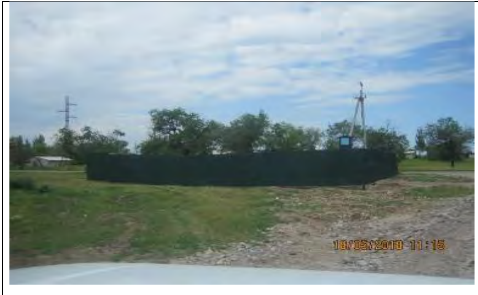
Рисунок 55 Восстановленная скважина для снабжения завода водой
