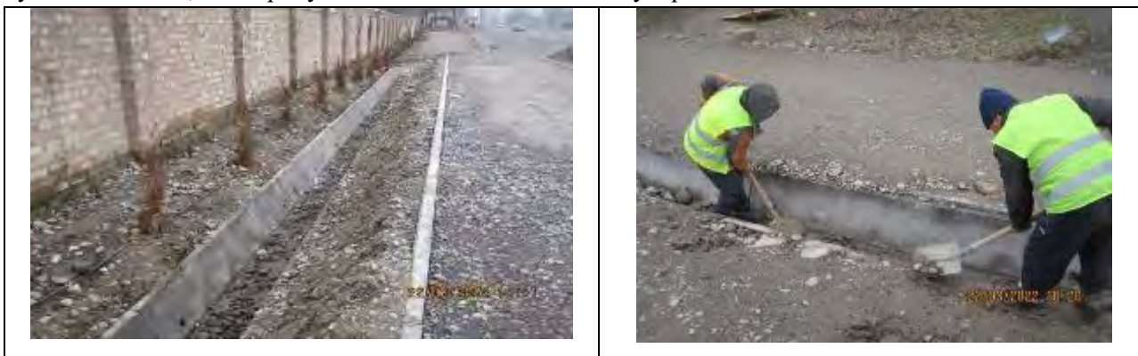
Рисунок 54 Очистка водопропускных лотков
