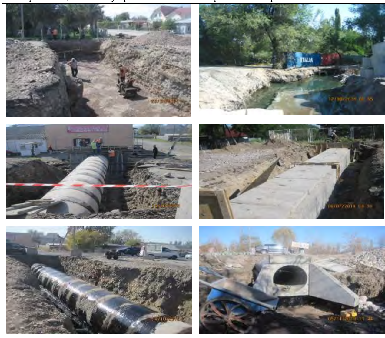
Рисунок 50 Строительство водопропускных труб.
