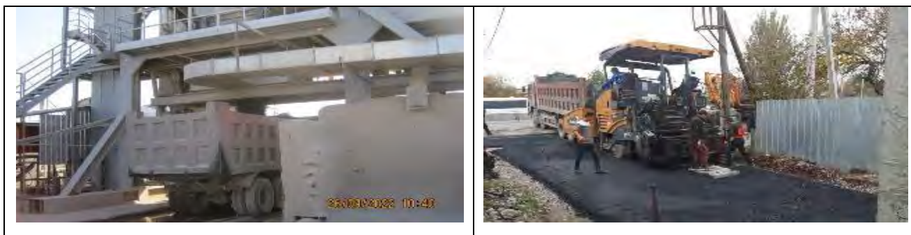
Рисунок 68 Загрузка асфальтовой смеси в самосвалы и выгрузка ее в асфальтоукладчики
