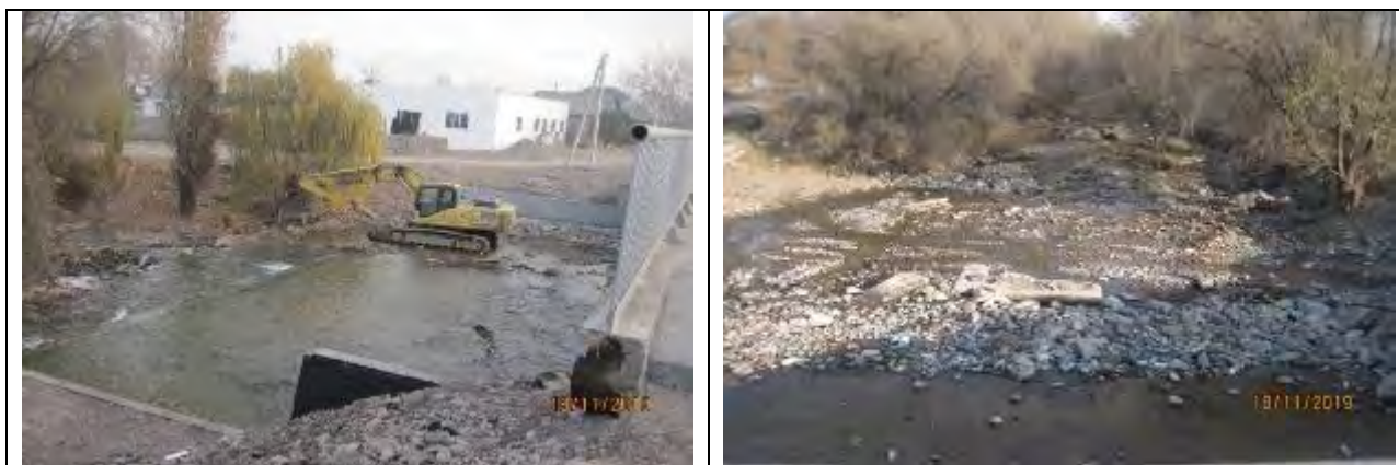
Рисунок 40 Очистка русла реки Сокулук от строительных отходов
