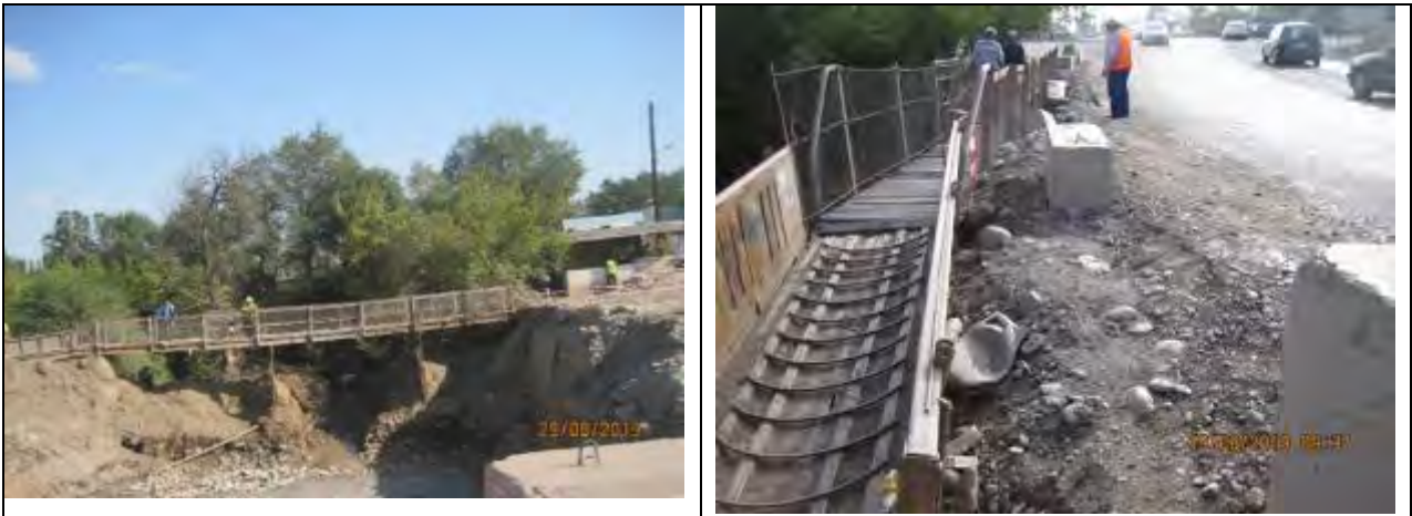
Рисунок 48 Пешеходный мост на канале Крепостной до строительства нового моста
