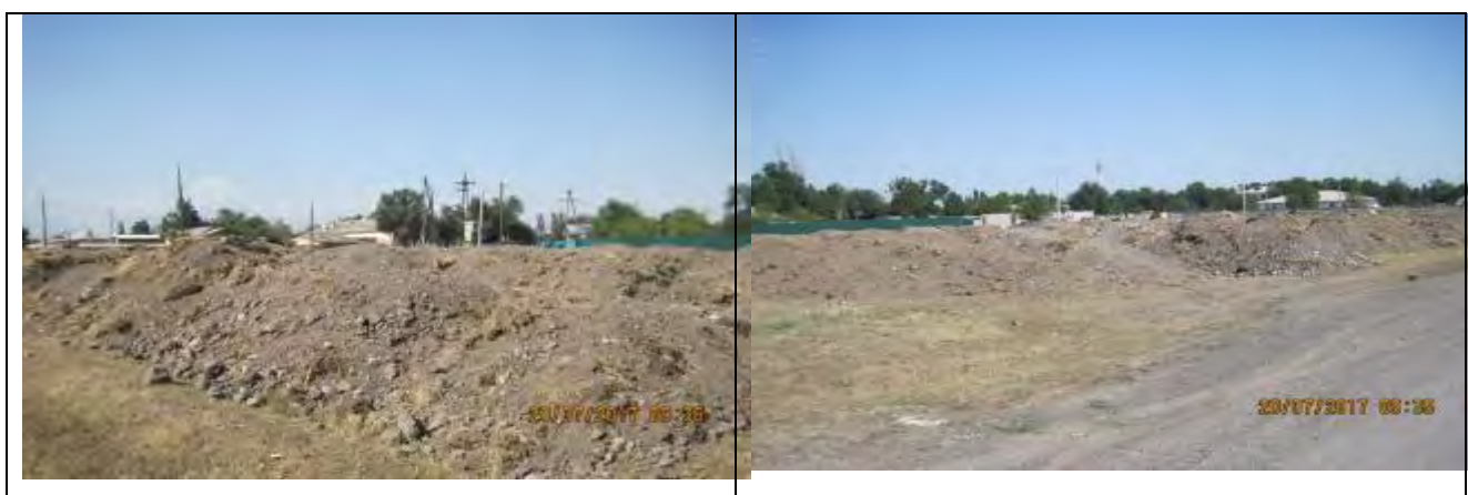
Рисунок 15 Отвалы снятого и вывезенного почвенного грунта
