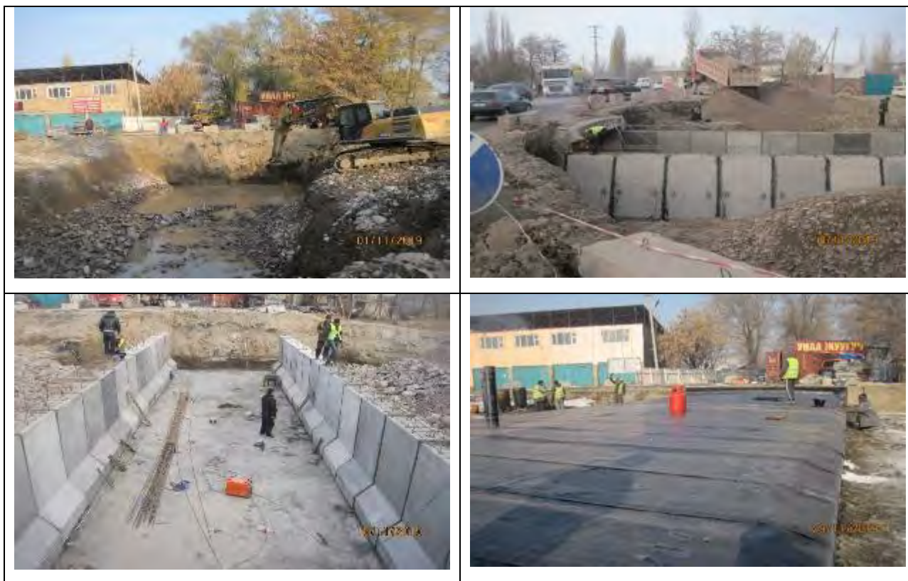
Рисунок 44 Строительство моста на канале Джантай
