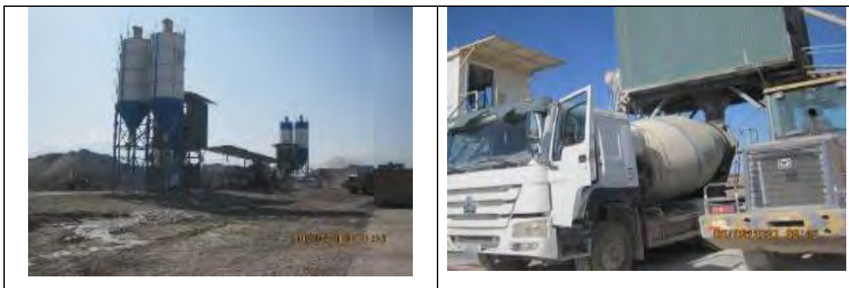
Рисунок 66 Заправка бетоном бетоносмесительной машины
