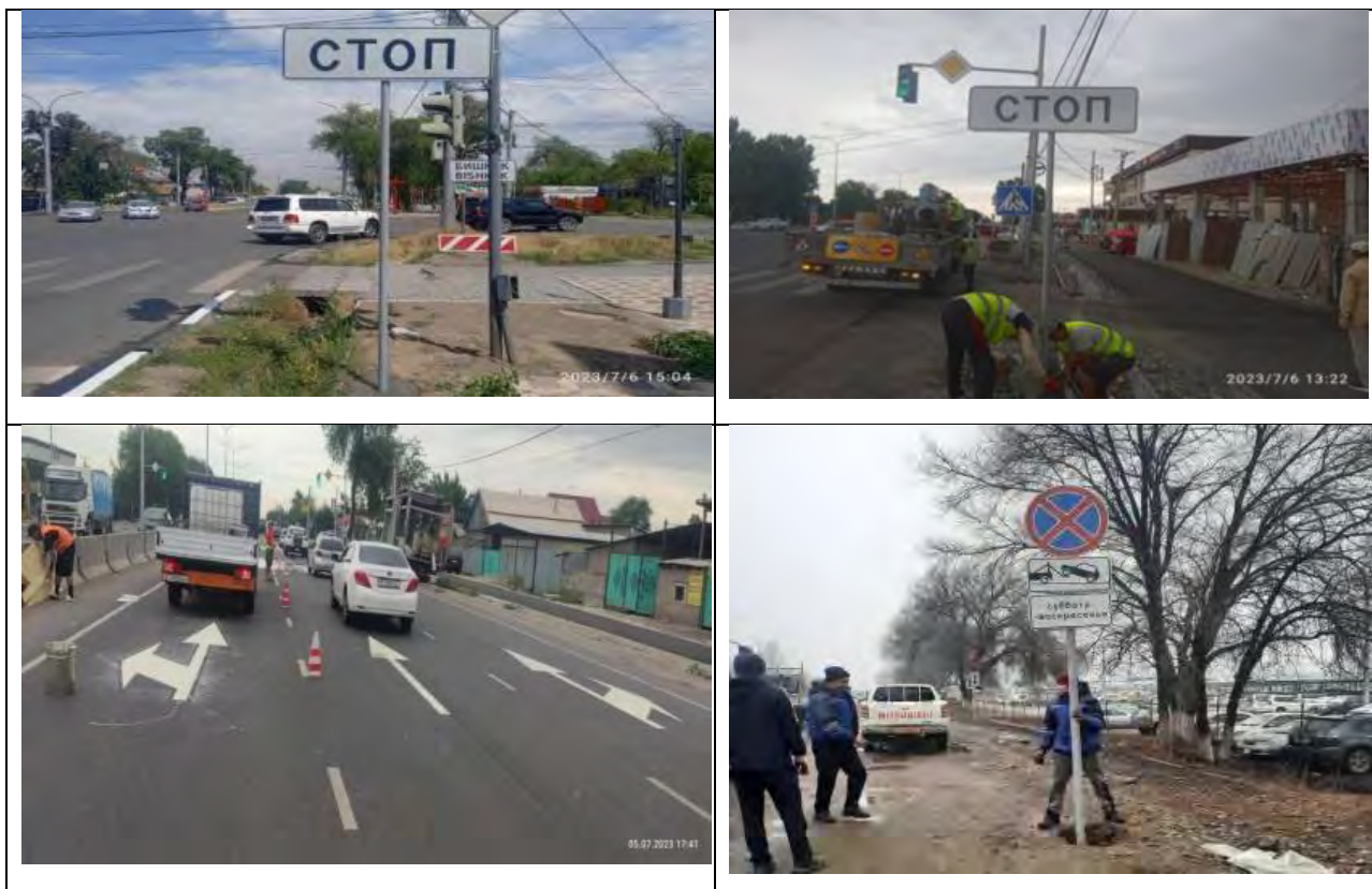
Рисунок 68 Установка дорожных знаков и нанесение дорожной разметки
